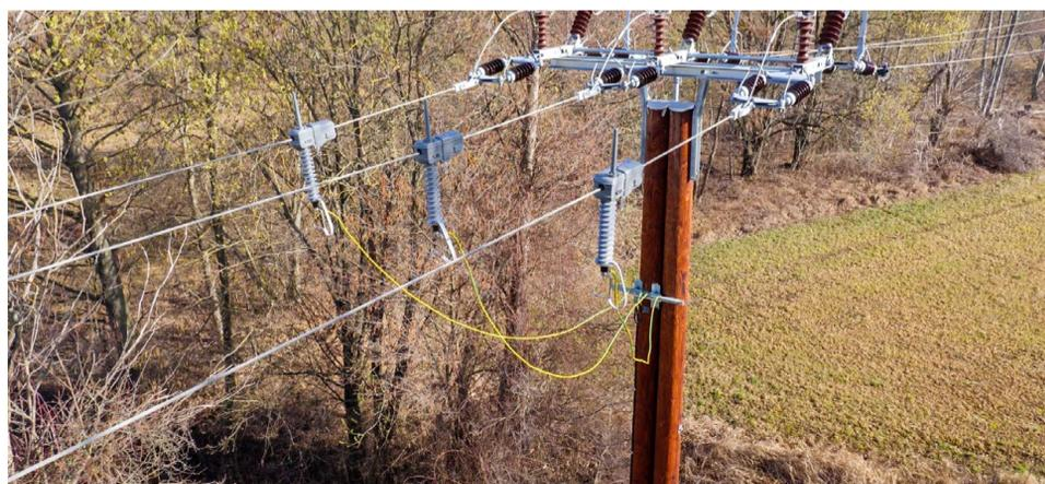
Alle 15 Minuten liefern die Sensoren wichtige Messdaten zu Seiltemperatur, Stromspannung und Phasenwinkel.
