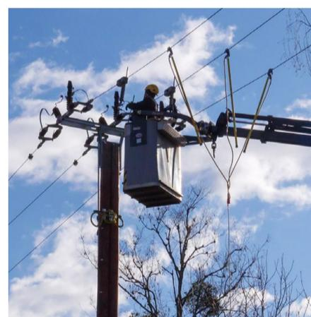
Die Montage der drei Aclara Sensoren erfolgte innerhalb einer halben Stunde mittels Hubsteiger.
