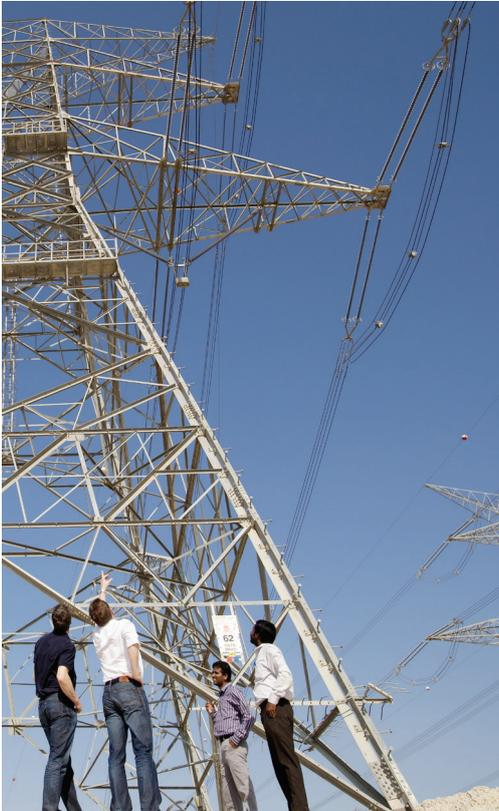
400 kV Abspannmast für ein 4er Bündel
